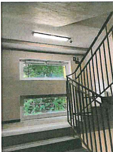
Widoczne okna napowietrzające uruchamiane przez system oddymiania grawitacyjnego.
