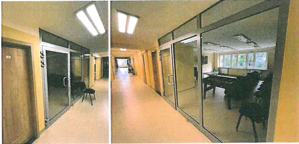
Przeszklenia bez odporności ogniowej w obudowie drogi ewakuacyjnej na II i III piętrze.
